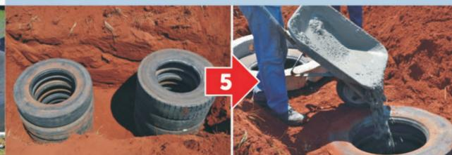
Coloque os módulos na vala. O fundo de cada módulo deve ser compactado para receber uma camada de, no mínimo, 5cm de concreto. Em seguida, instale os anéis.
