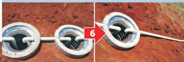
Instale as tubulações. No 1º módulo faça a instalação de entrada do tubo PVC e curva de 90° com profundidade de 90cm. Instale a tubulação de saída na altura do 1º módulo e insira um joelho de 90° na sua extremidade. É 1,5m de tubo, sendo que 20cm avançam para o interior do 2º módulo. Na extremidade, instale um joelho de 90° e um tubo com profundidade de 90cm. O tubo que servirá de sumidouro é instalado na altura do 2º módulo. Agora aplique a fita aluminizada entre o pneu e os anéis.
