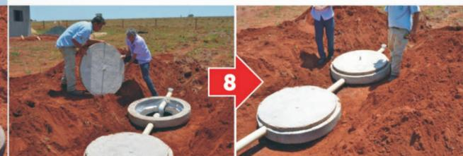
Instale a tampa com furo central no 1º módulo e a tampa compacta no 2º módulo. Instale também um cano no furo da tampa do 1º módulo de 0,5 polegada e 1,5m de altura para liberar os gases gerados. Ele deve apontar para o céu.
