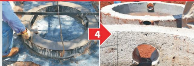
Fabrique você mesmo os 2 anéis e as 2 tampas de concreto armado para instalar a tubulação e fechamento da fossa. Use ferro, areia, cimento e brita. Faça a massa de concreto e coloque-a na forma que deve ter o diâmetro da circunferência dos pneus e altura de 14cm. A forma do anel deve ter entrada e saída para um tubo de 100mm. As tampas devem ter a mesma circunferência do pneu e espessura de 5cm. Uma delas é compacta e a outra tem um furo central de 0,5 polegada.
