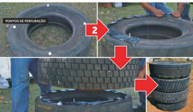
Monte os módulos. Primeiro perfure os pneus nos pontos destacados na foto. Depois, aplique a fita aluminizada entre os pneus para então parafusá-los. A manta deve ter a circunferência do pneu e sua finalidade é vedar os módulos para impedir a saída de esgoto.
